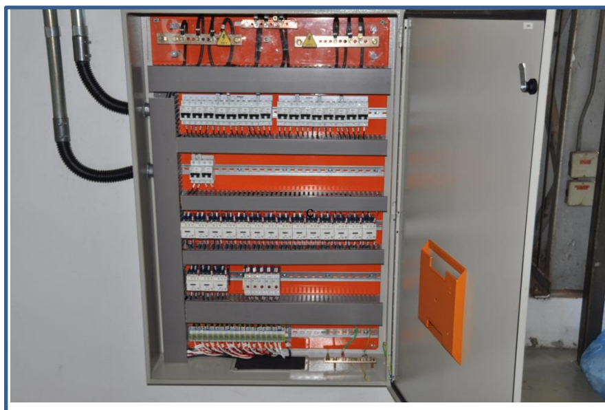
Figura 7: Ilustração de um quadro de automação de iluminação na configuração B
